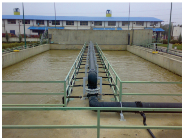
شکل ۱: واحد هوایی عمقی تصفیه خانه آق قلا
