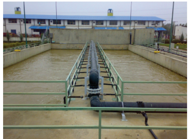
شکل ۱: واحد هوایی عمقی تصفیه خانه آق قلا
